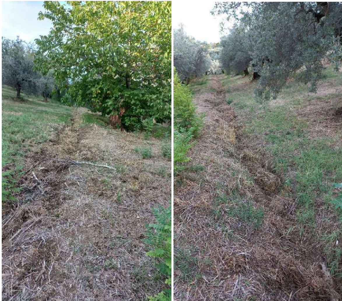
Tipologia del fosso di guardia esistente a monte della frana – si noti la pacciamatura che lo riempie atta a diminuire la velocità dell'acqua ad evitare erosione
