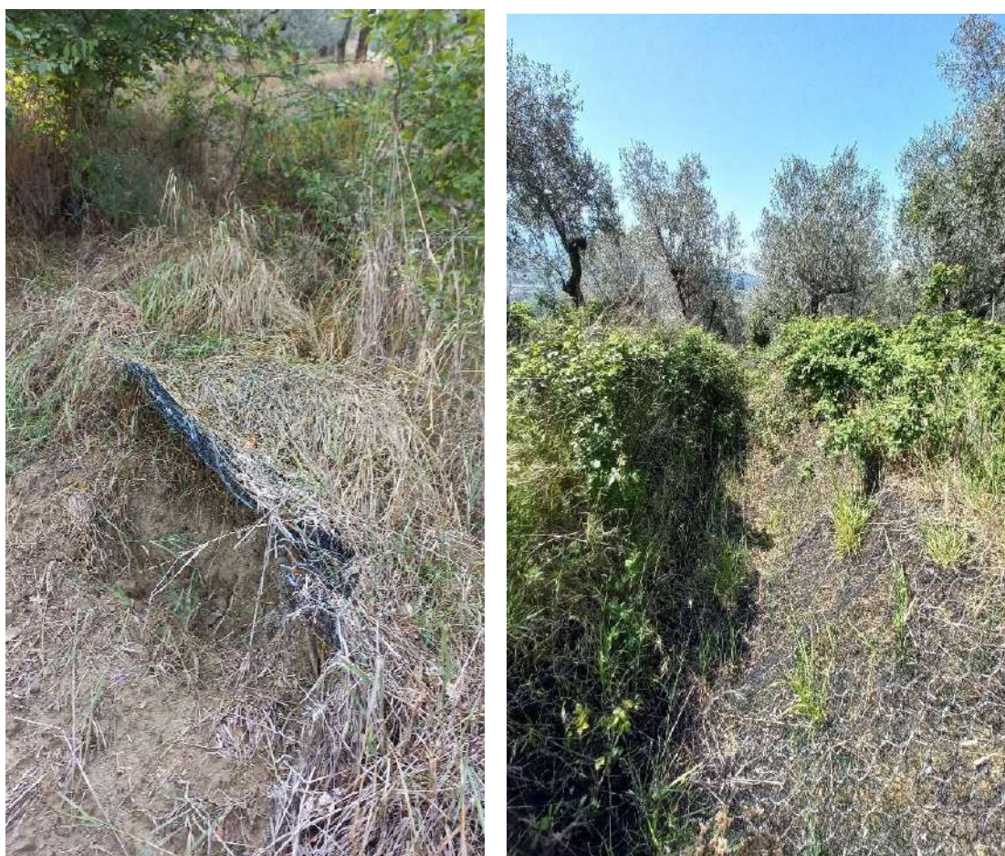
Stato del canale di drenaggio esistente – si noti a destra la geogriglia rialzata dalla deformazione e la sezione drenante quasi completamente ostruita.
