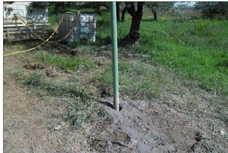
Installazione tubo inclinometrico
